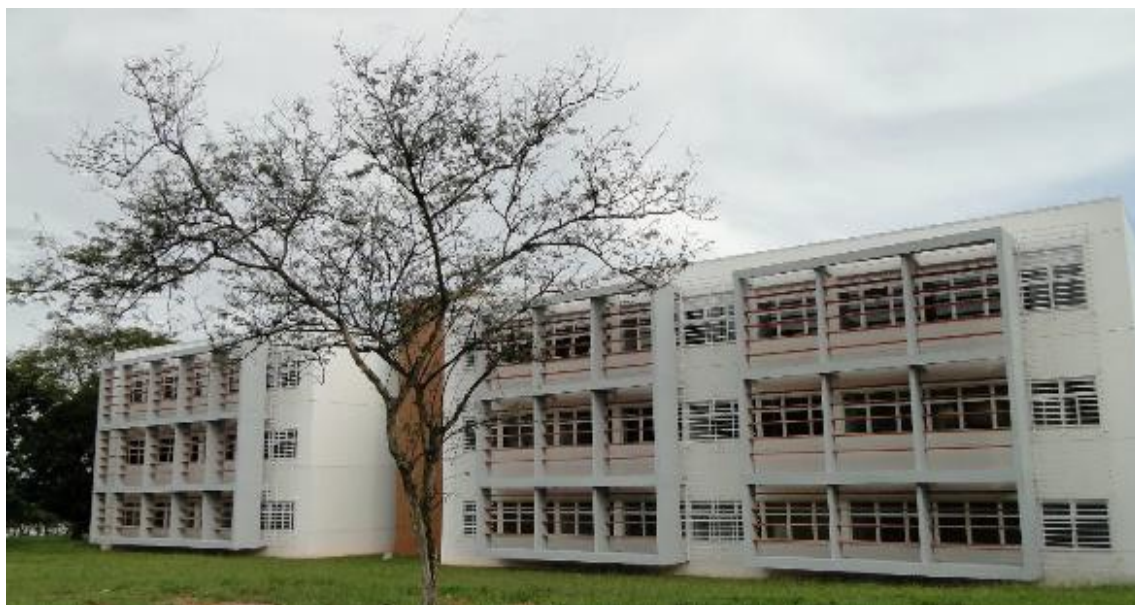
Figura 1: Vista lateral do novo prédio do Departamento de Engenharia Florestal e Programa de Pós-Graduação em Ciências Florestais da Universidade de Brasília.
